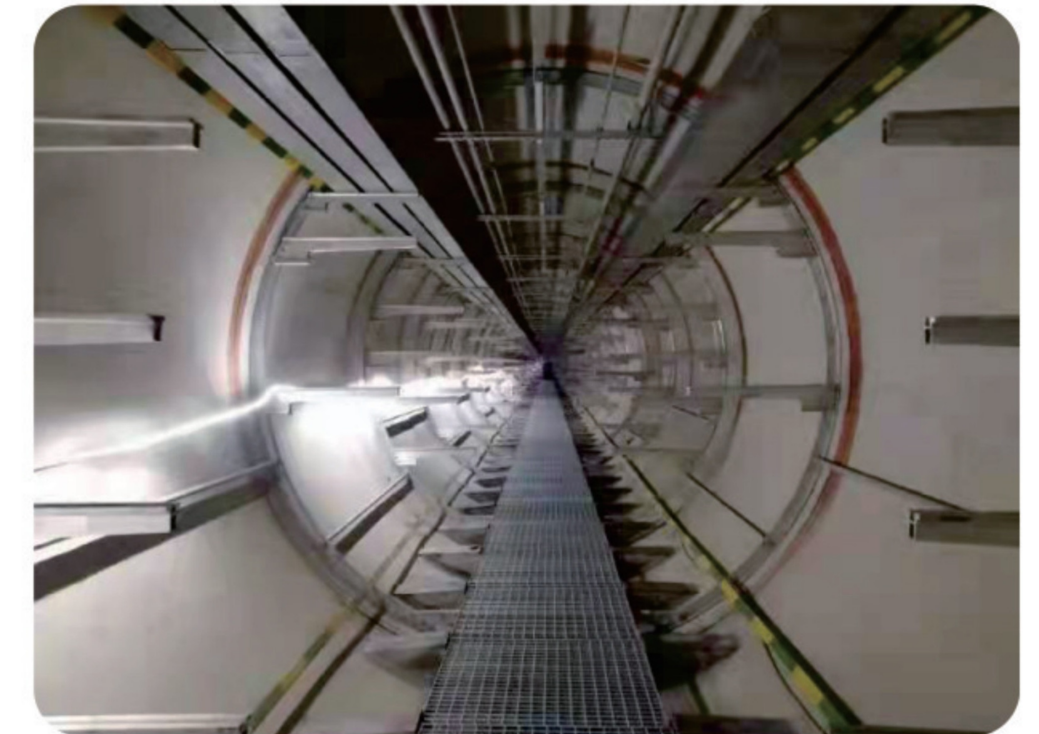
弧形管廊铝合金 电力支架 安装实景
