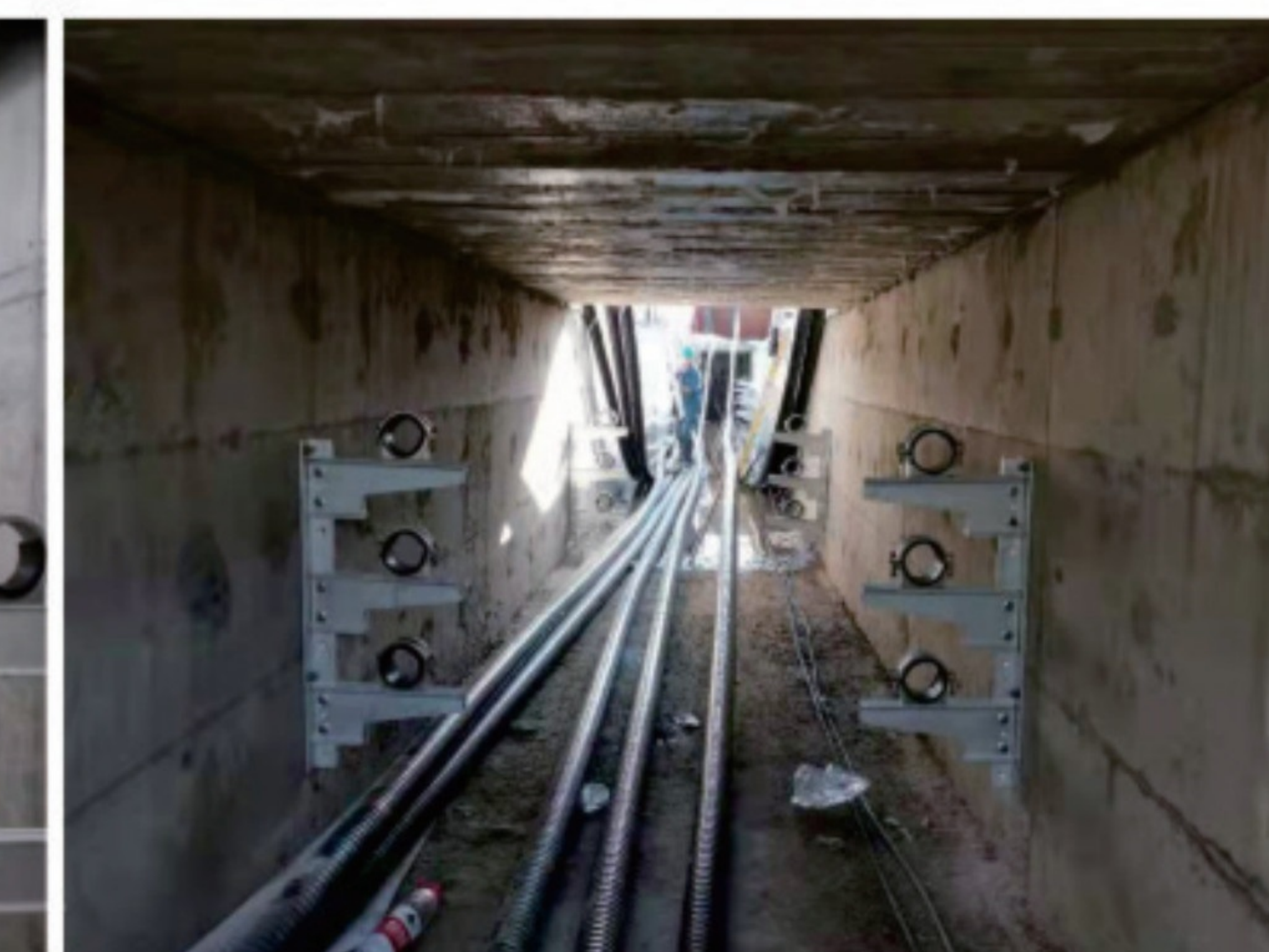
高压电力舱铝合金电力支架一拖三安装实景
