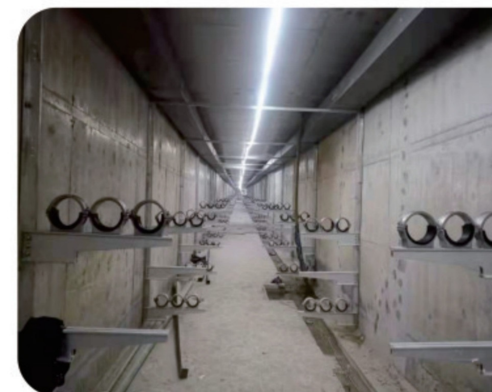
高压电力舱铝合金电力支架一拖三安装实景
