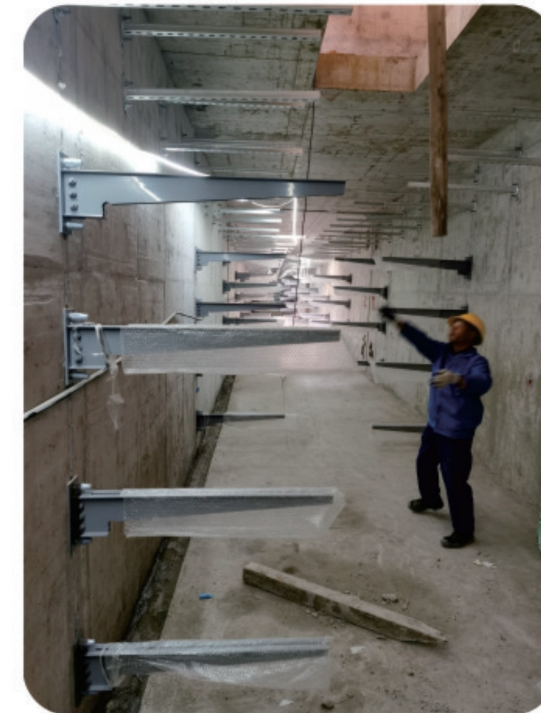
高压电力舱铝合金 电力支架单套式 安装实景
