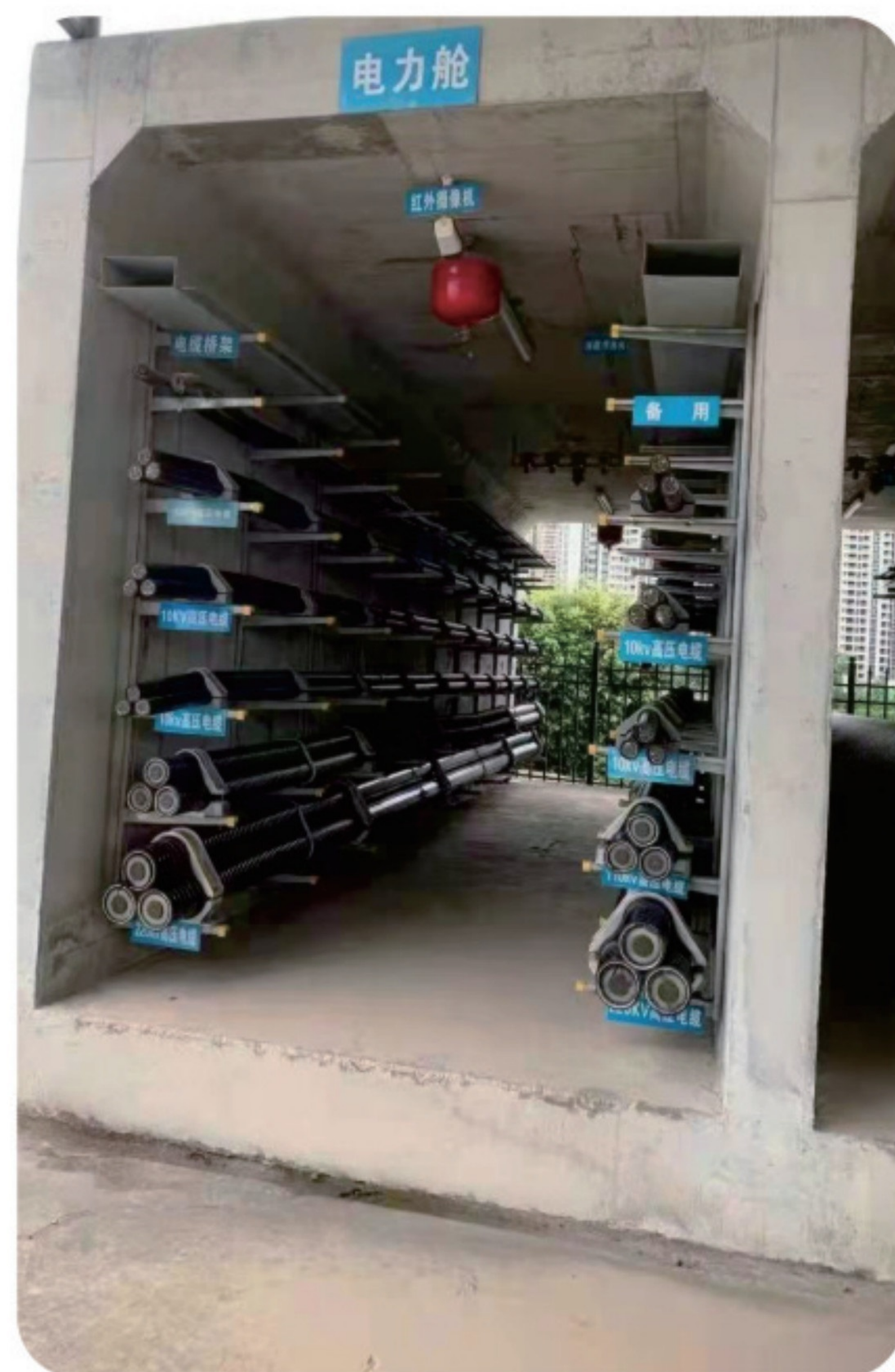
安装实景展示
