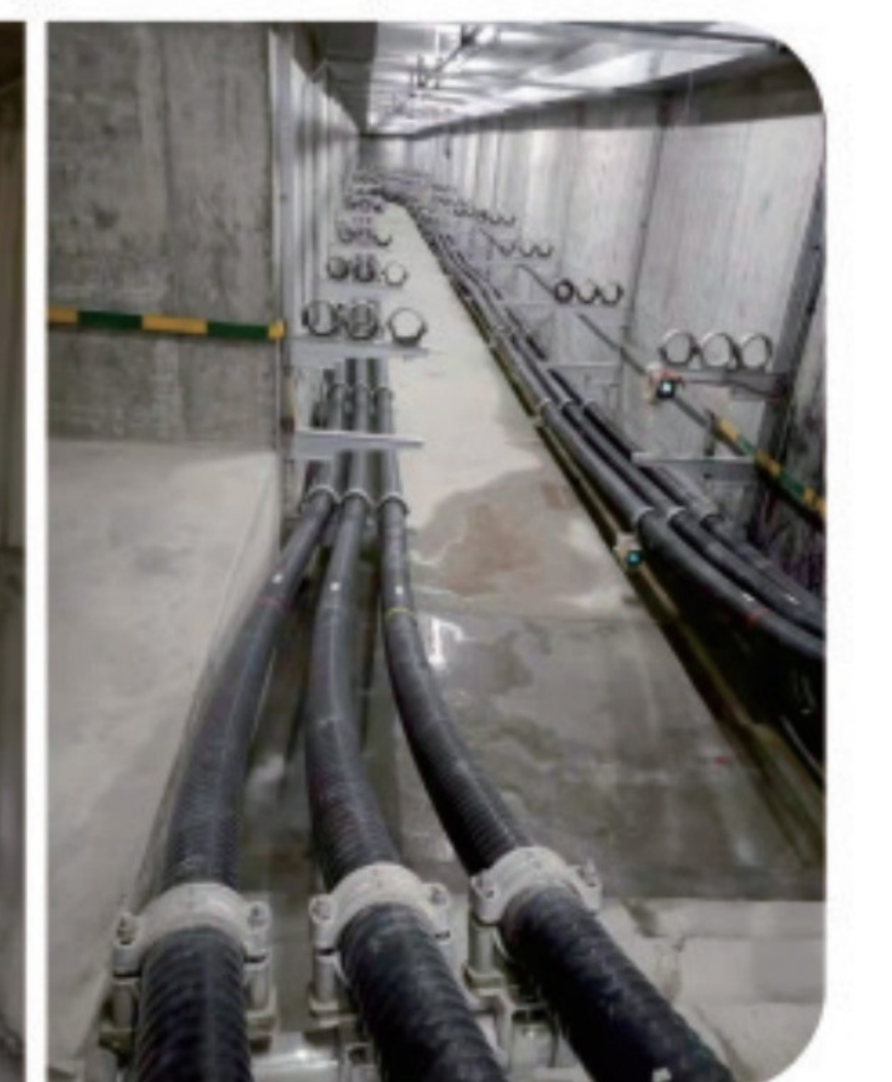
高压电力舱铝合金 电力支架一拖三 安装实景
